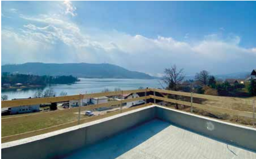
BESTSELLER – die Baustelle in Pörtschach am Wörthersee läuft bereits auf Hochtouren!
