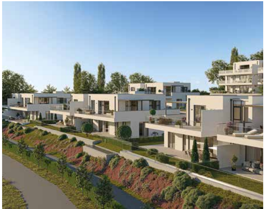
BELETAGE – das neue Bauprojekt am Ruckerlberg, das Sie mehr als überraschen wird!
