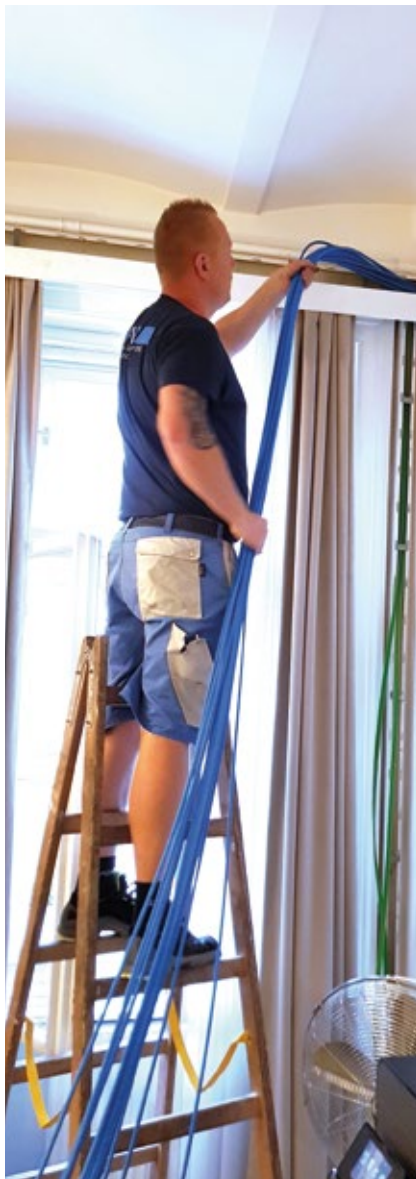
Die Kabel müssen richtig in das Panel gelegt werden
