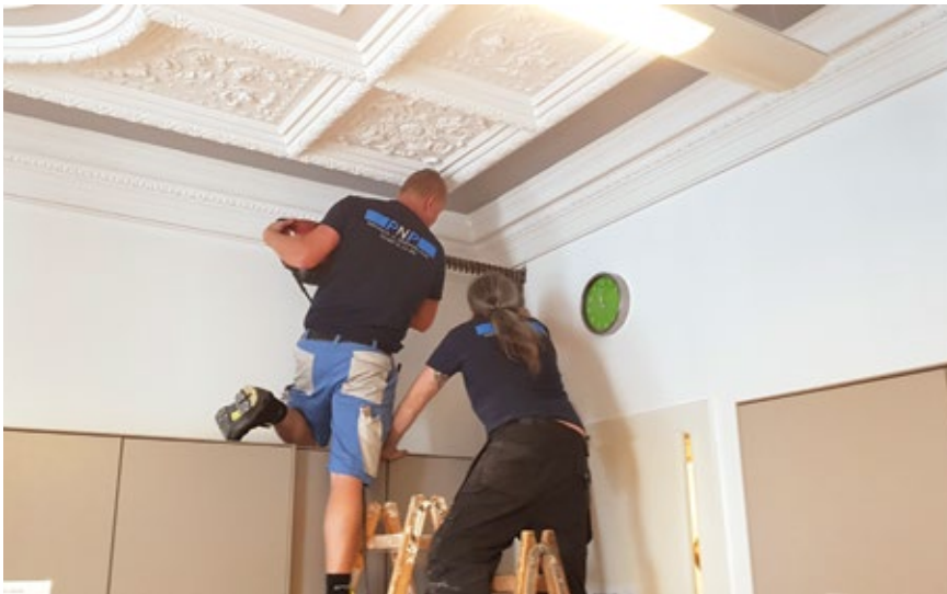
Für die professionelle Neuverkabelung mussten Mauern durchbohrt werden
